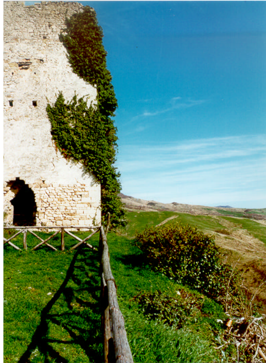
Foto 1: corona del dissesto che interessa direttamente la torre del borgo
